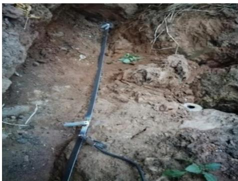
Рис.1. Монтаж заземления
